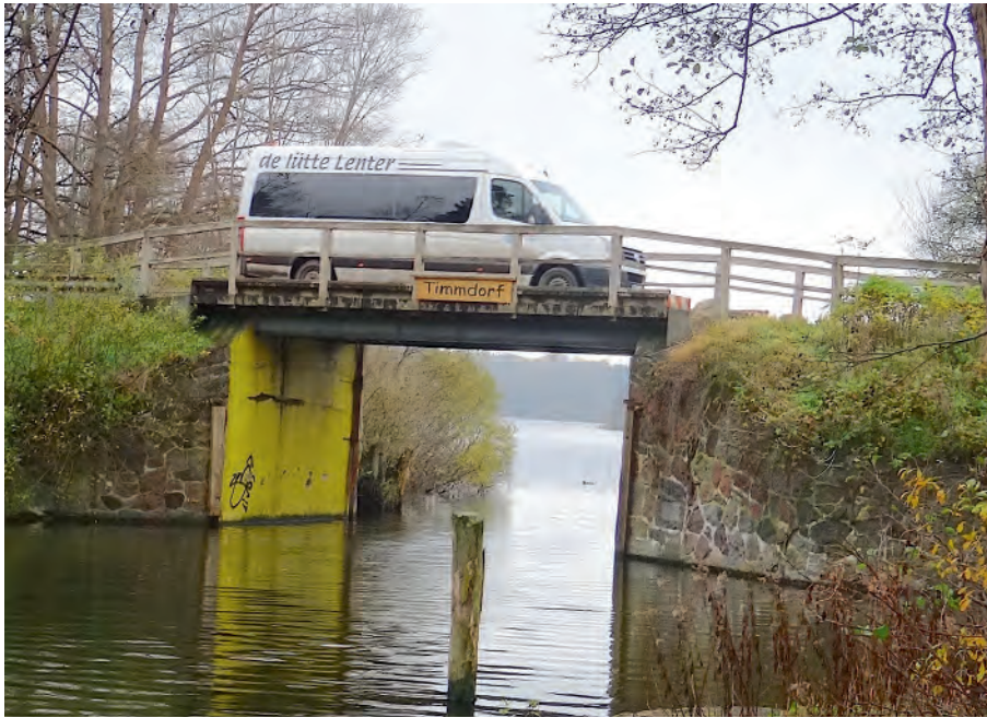
Abb. 4: De Lütte Lenter auf der Brücke in Timmdorf.
